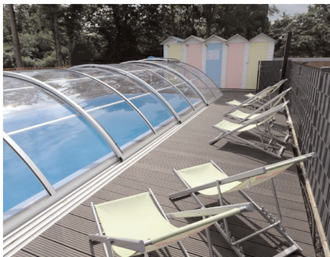
Der überdachte Pool mit Gegenstromanlage
